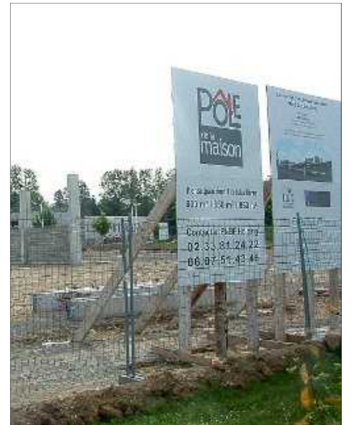
Le Pôle de la maison est en cours de réalisation.
