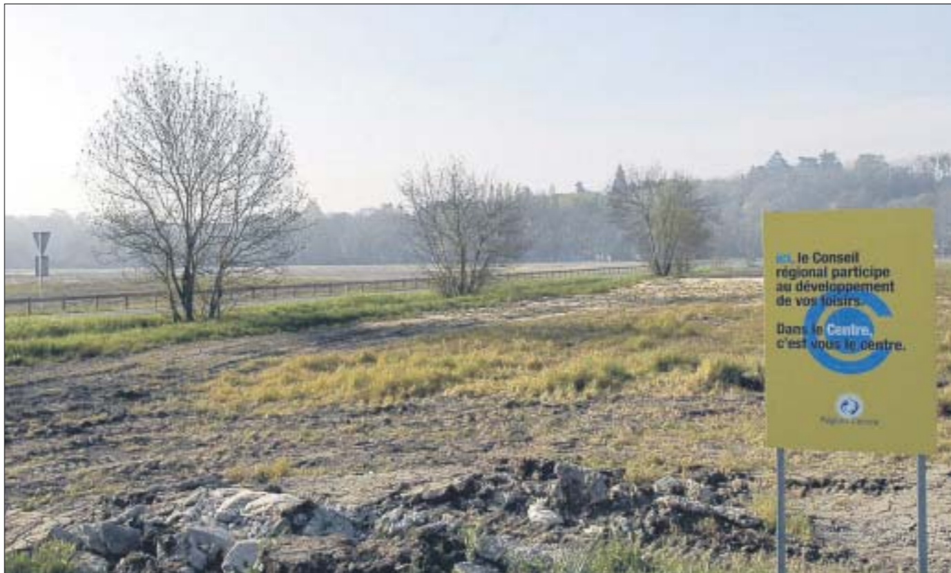
Coût global de la construction du golf 18 trous : 1,7 million d'euros, « la moitié d'un gymnase ». Ce concept, récent en Europe, a surtout été développé en Espagne. En France, on en compte une quinzaine.
